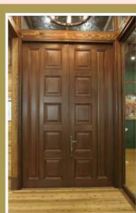
Yellow cedar door and door frame
